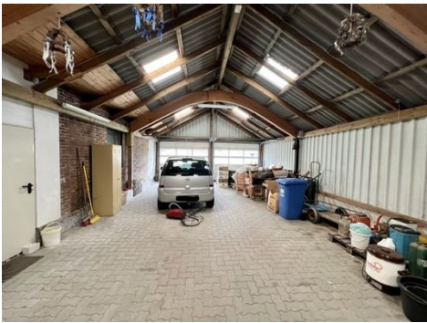
Halle von 1995 - Innenansicht
