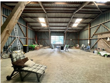
Halle von 1978 - Innenansicht
