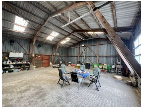
Halle von 1978 - Innenansicht
