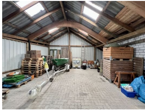
Halle von 1995 - Innenansicht
